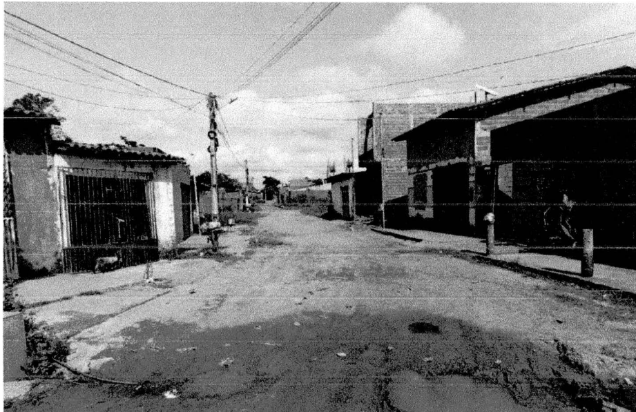
FOTO 02: TRV. 04, BAIRRO BOM SUCESSO
